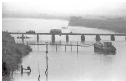
▲荒川にかかる昭和30年代の(旧)笹目橋。台風などの増水の際には水面下に潜ってしまう冠水橋
