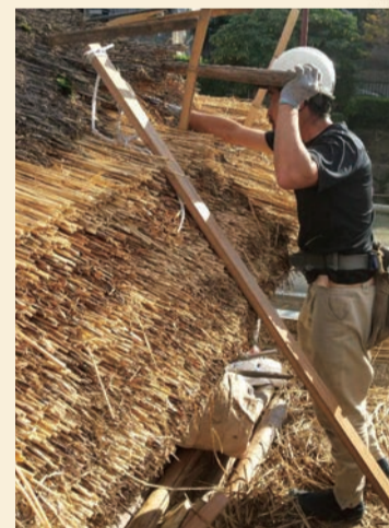
差し茅修繕の様子▲
