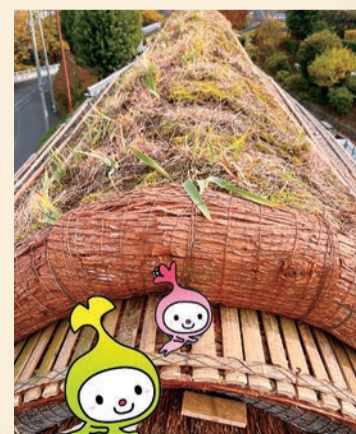
くれぐし修繕の様子▲
