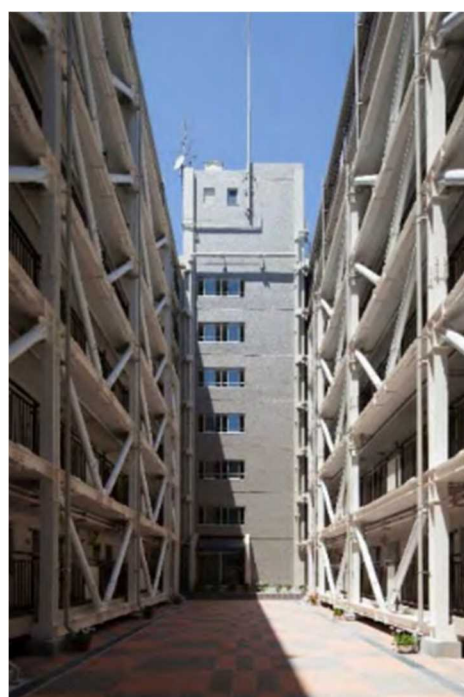
図表 2-73 耐震改修後のマンション
