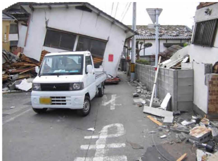
熊本地震での道路閉塞現場
