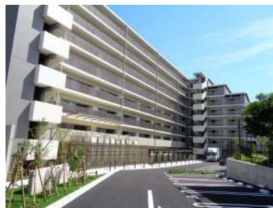
建替が進む西大和団地
