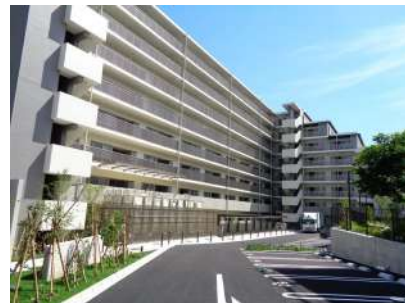
建替が進む西大和団地
