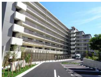
建替が進む西大和団地
