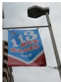
フラッグ共架に対応した 照明柱によるにぎわい演出
