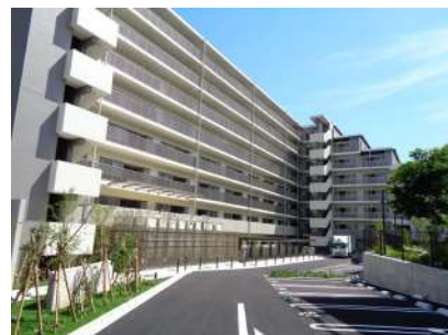
建替が進む西大和団地
