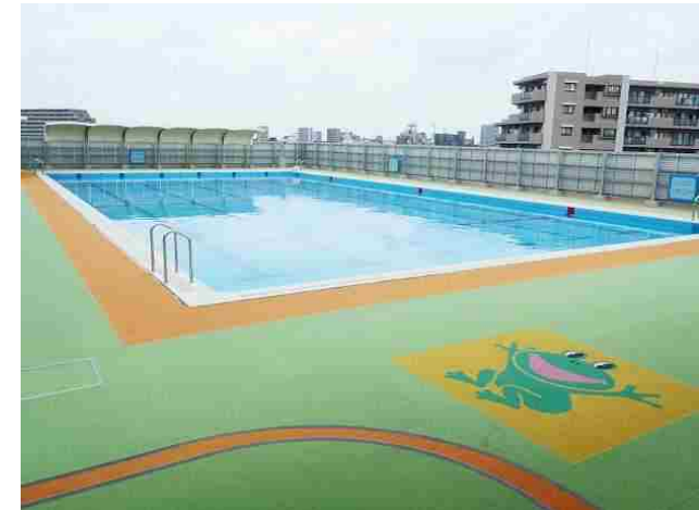
体育館の屋上にプールを設置
