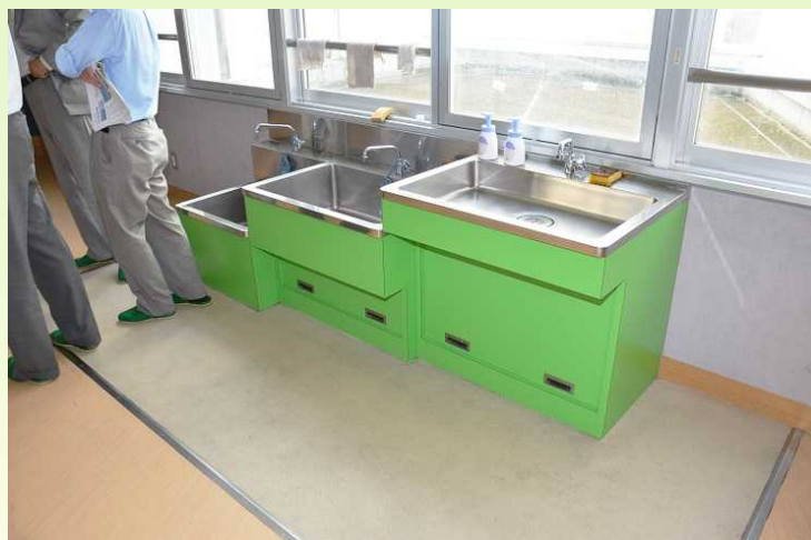
トイレ前には、3段階に分かれた手洗い場を設置
