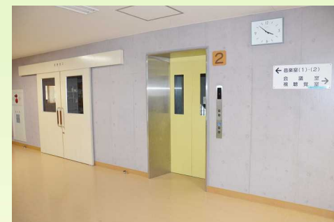
配膳室脇にエレベータを設置
