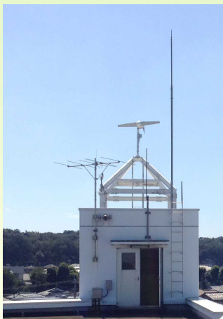
風力発電装置
