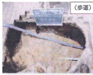
下水道管の老朽化に伴う道路の陥没（出典）東京都
