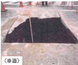
下水道管の老朽化に伴う道路の陥没（出典）東京都
