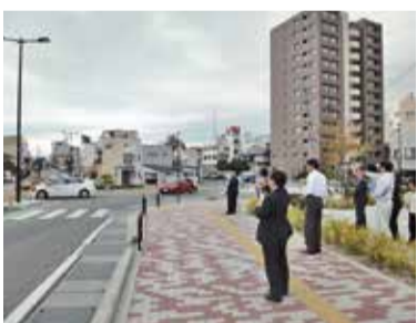
信号機のないドーナツ型の交差点「環状交差点」(ラウンドアバウト)。標識と新たなルールにより事故防止と渋滞緩和が期待される。
