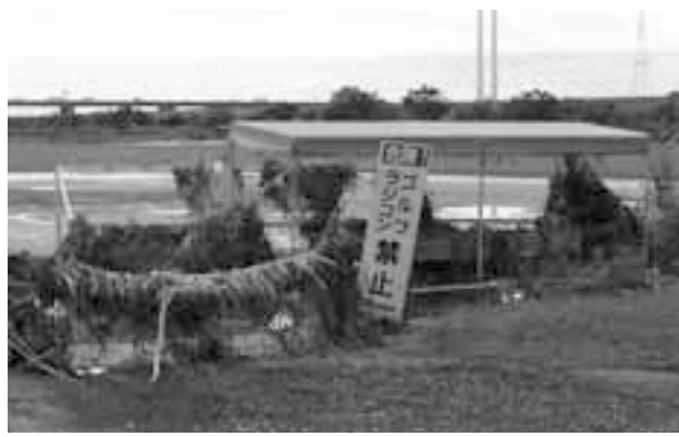
▲台風9号により被害を受けた荒川河川敷運動公園
