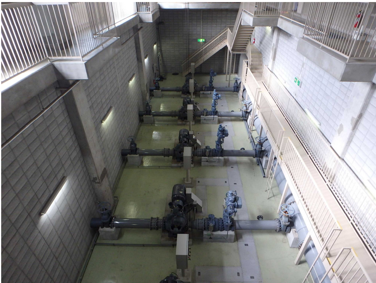
<南浄水場 配水ポンプ室>
