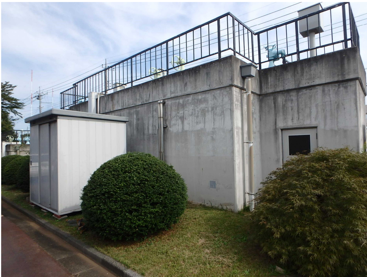
〈南浄水場 着水井〉
