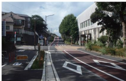
1期区間バス専用車線整備
