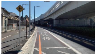
2期区間バス専用車線整備
