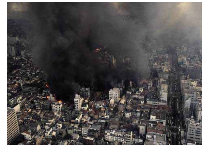
阪神・淡路大震災の被災状況
