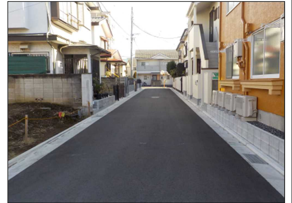
区4.8-2号線(施工済み)
