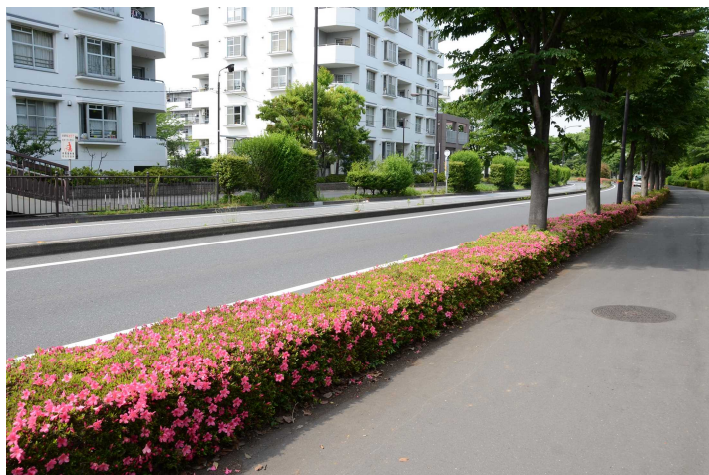
東京外かく環状道路 側道（市道 524 号線）
