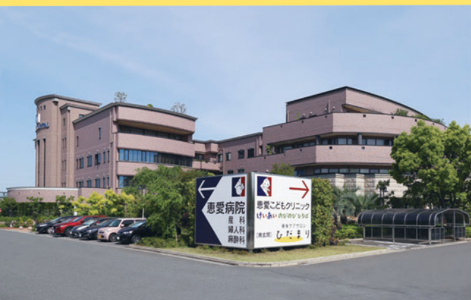
恵愛病院全景/駐車場250台
