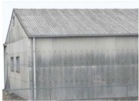
石綿使用のスレート波板
