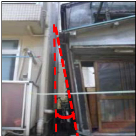
写真3 傾斜している空家等の参考例
