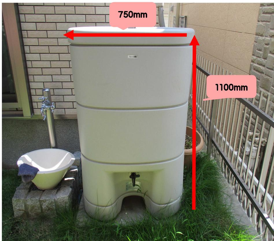
一例ですが、この雨水タンクは容量 150ℓ、縦 1100mm、横 750mm、重さ 17kg となっています。和光市内に設置されている雨水タンクではこのタイプのもが多く見られます。
