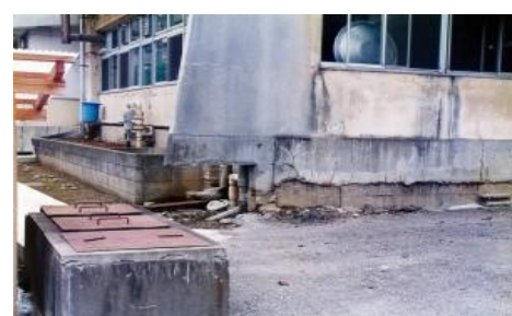
抜け上がった建物の基礎
