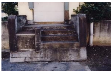
抜け上がった建物の基礎
