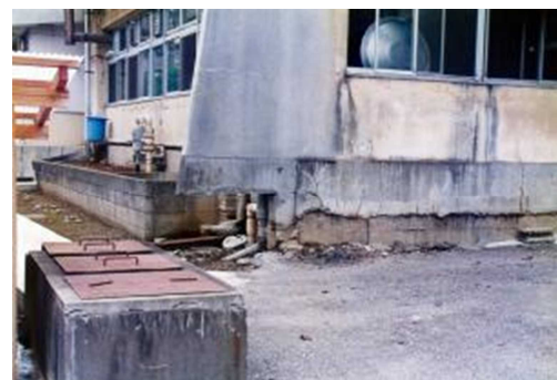
抜け上がった建物の基礎
