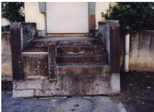
抜け上がった建物の基礎
