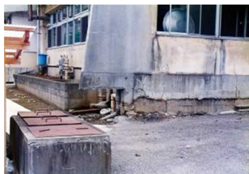
抜け上がった建物の基礎
