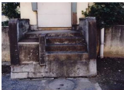
抜け上がった建物の基礎
