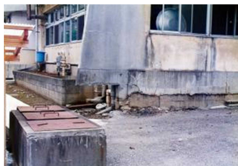
抜け上がった建物の基礎
