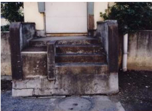
抜け上がった建物の基礎
