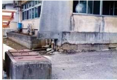
抜け上がった建物の基礎
