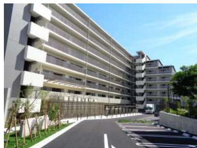
建替が進む西大和団地
