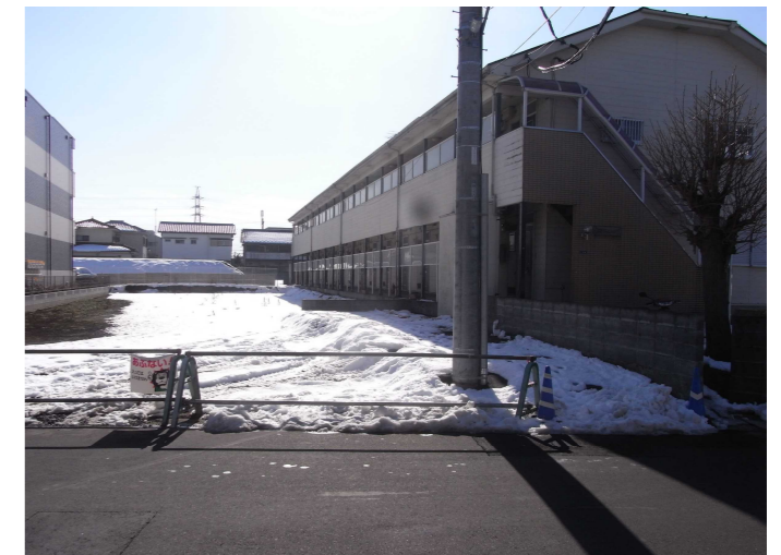
⑤：区12-2号線の街路築造工事を進めています。
