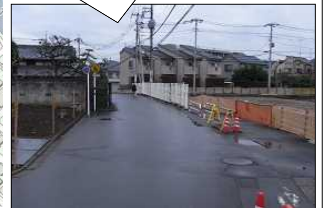
車両通行止め(区間約40m)となる妙蓮寺通り
