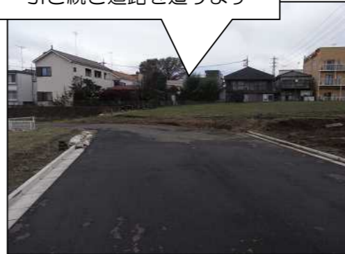
引き続き道路を造ります
