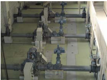
<南浄水場 配水ポンプ室>
