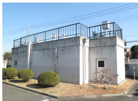
＜南浄水場 着水井＞
